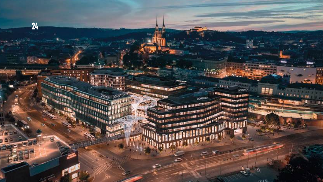
Z Dornychu se stane prestižní kancelářská adresa v Brně.
